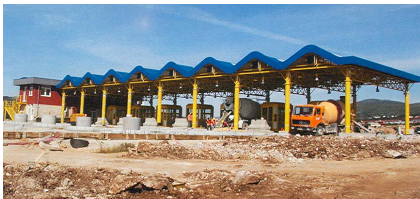
Gradilište naplatnih kućica u Dugopolju
