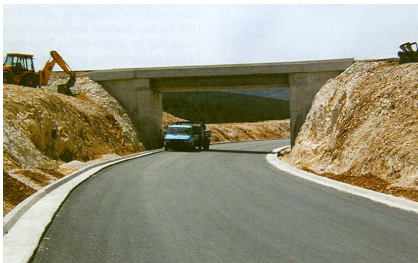
Prijelaz željezničke pruge preko odvojka čvorišta Vrpolje
