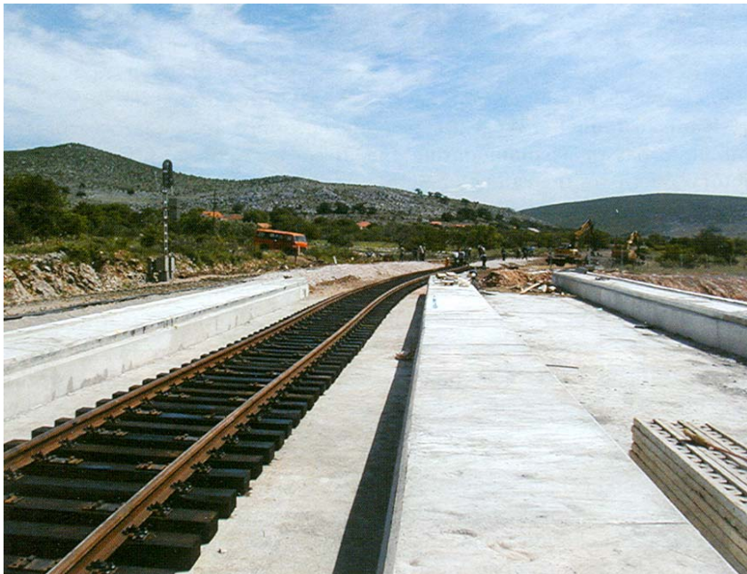
Gradilište nadvožnjaka Vranjići
