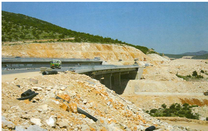
Pogled na gradilište vijadukta Gajina
