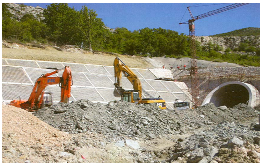
Uređivanje pokosa pokraj zapadnog portala tunela Konjsko
